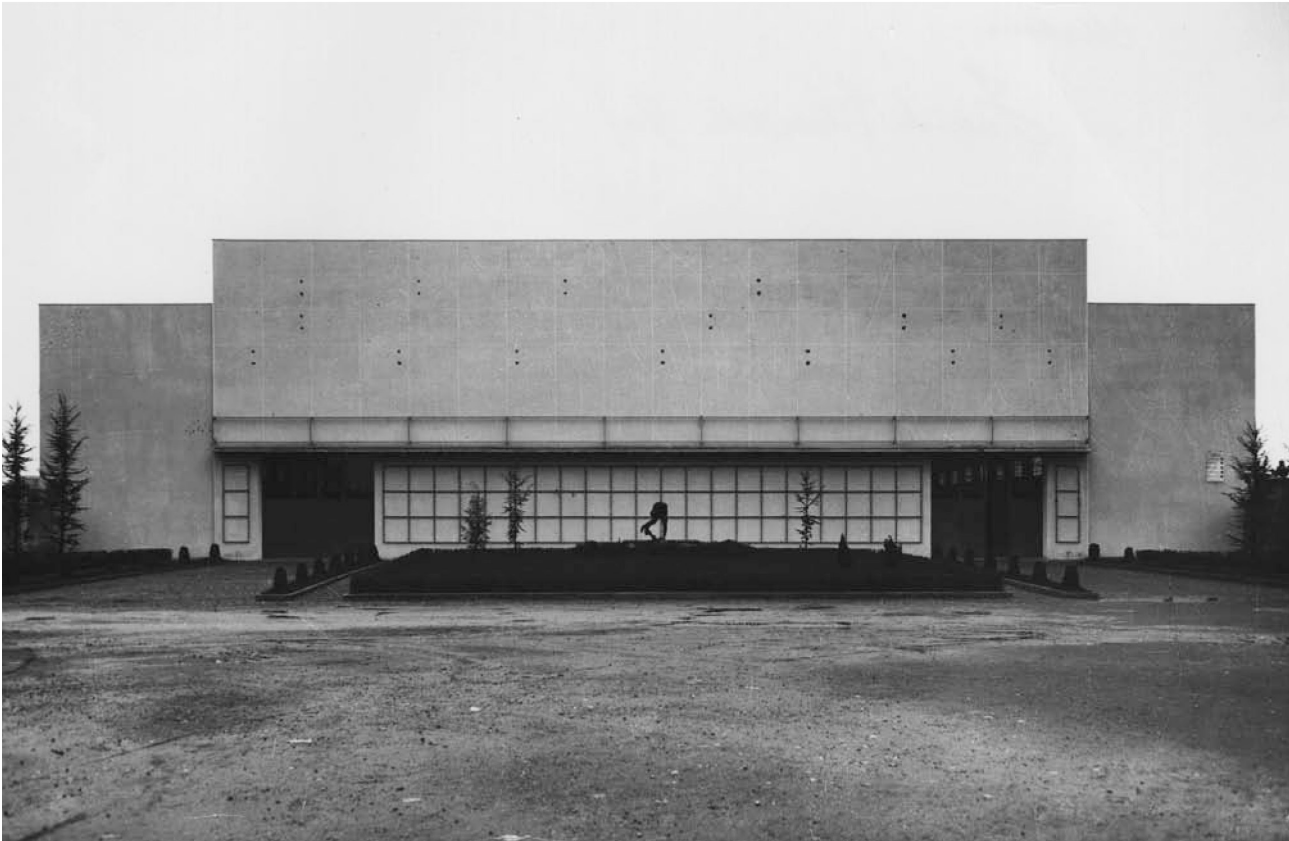
Il vecchio Palazzo dello Sport appena costruito.
